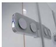
Vnútrotná úprava závesov: sivá podložka pod závesom a chrómové krytky skrutiek
