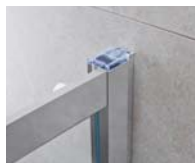
Výrovnanie nerovností: regulácia na stenových profiloch
